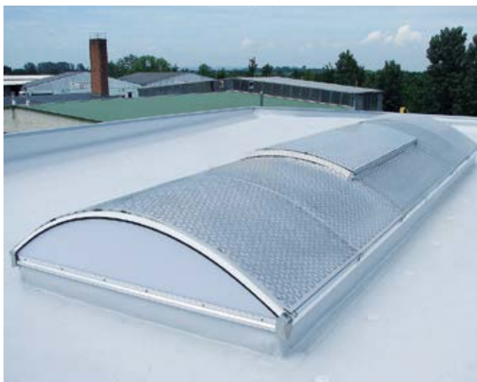
Abb.: Durch individuelle Verschattungssysteme ist der Arbeitsplatz zu jeder Zeit optimal nutzbar. Lochbleche können den Lichtdurchlass von Tageslichtelementen um 10 bis 20% reduzieren.
